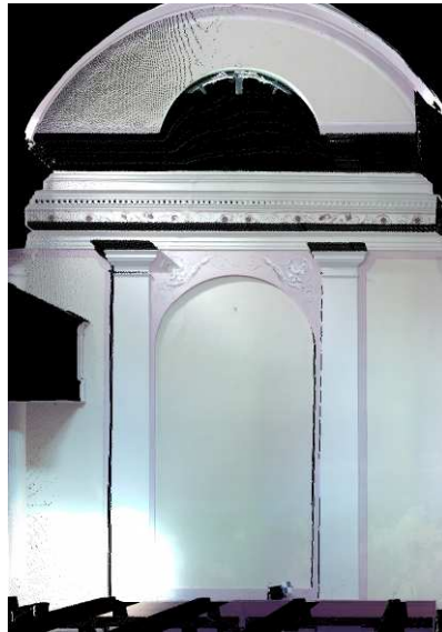
Ortofoto parete interna
