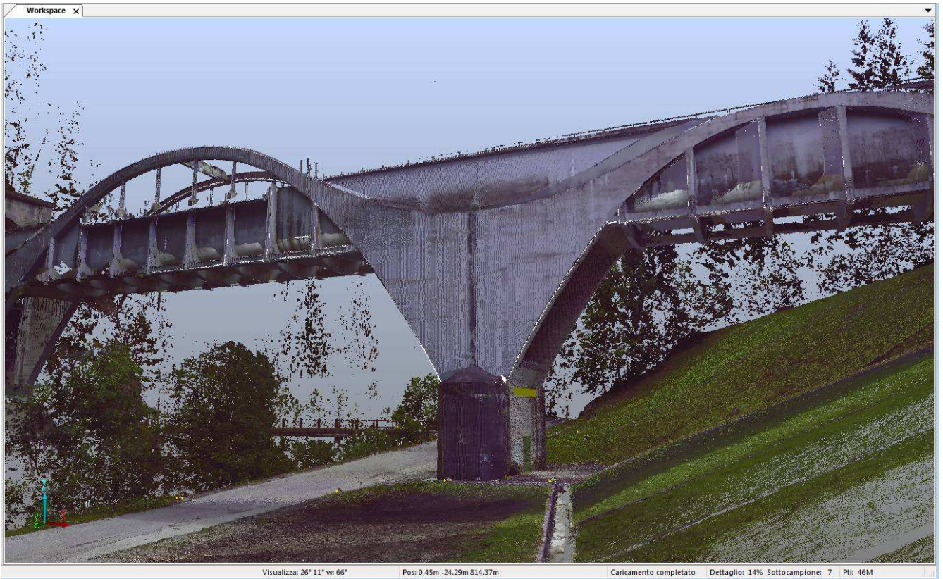
Rilievo PONTECANALE: vista 3D ricavata dalla nuvola di punti
